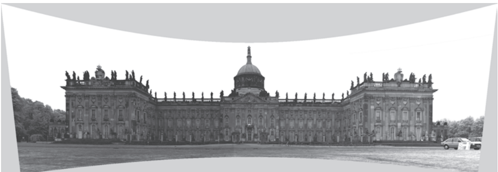
Abb. 5: Transformierte Panoramaaufnahme von Abb. 4.
