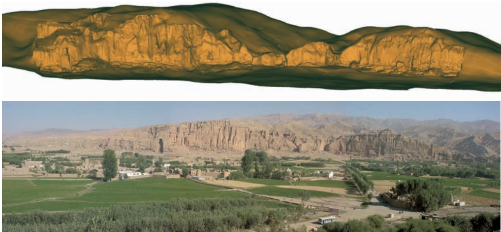
Abb. 11: Oben: Blick auf das DOM der erweiterten Felswand, bestehend aus dem SPOT 5-DTM und aus dem DOM der Felswand, abgeleitet aus Rollei 6006 Bildern. Unten: Eine Fotografie der gesamten Felswand.
