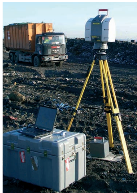
Abb. 1: Laserscanner HDS3000 im Deponie-Messeinsatz.
