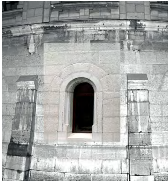
Abb. 6: Koregistrierung von Laserscanner- und Panoramascanneraufnahme
