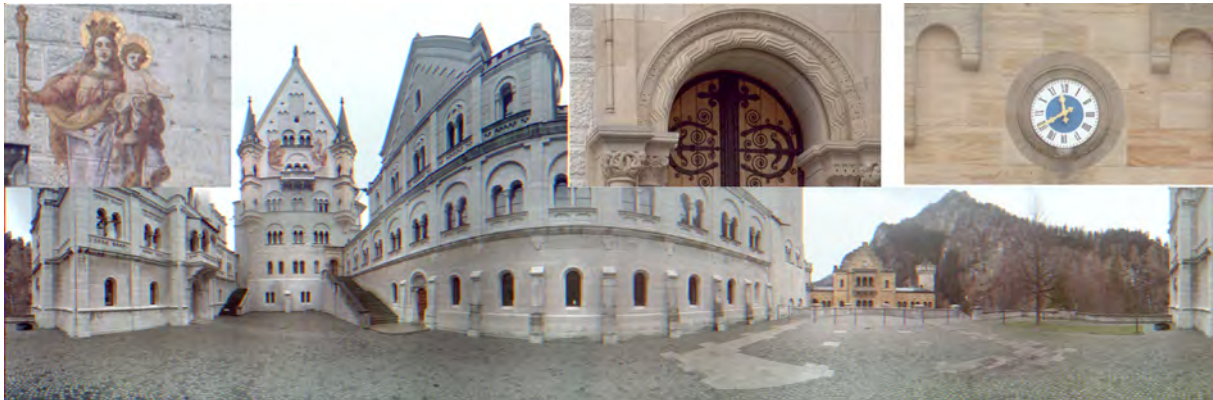
Abb. 2: 360° Aufnahme und drei Detailansichten vom Panoramascanner
