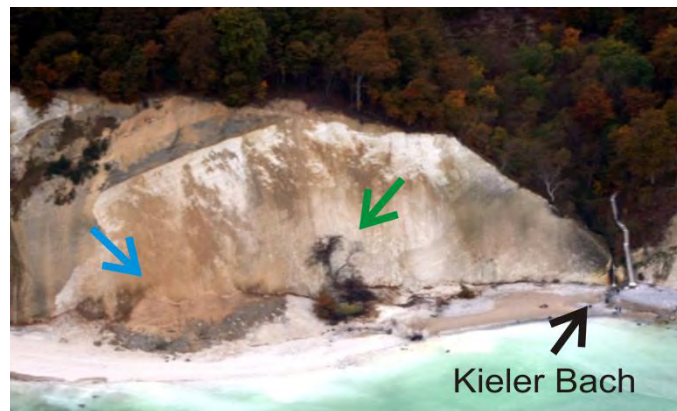
Abb. 7: Aufnahme nach der Rutschung [Foto: Tiepolt]
