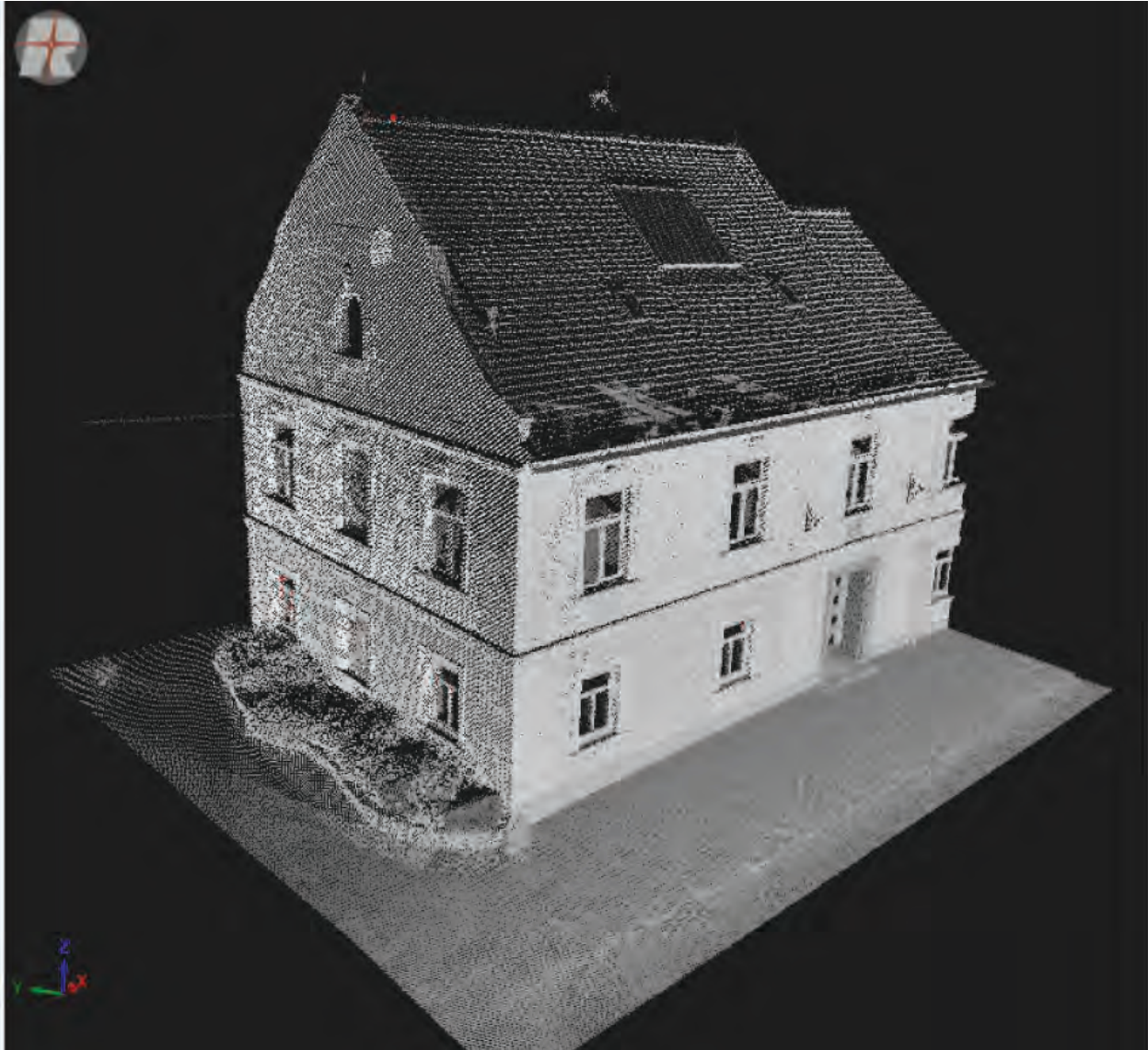
Abb. 7: Punktwolke eines Gebäudes, aufgenommen in zwei Vorüberfahrten, und insgesamt einer Kombination von 4 Scans. Die Graustufenwerte resultieren aus der Reflektivität der jeweiligen Oberfläche im Bereich von -25 dB bis +5 dB.
