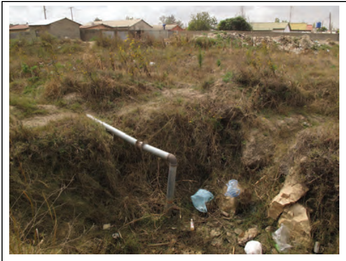
Abb. 6: Die lokale Wasserversorgung kann durch Kontamination aufgrund inoffizieller Mülldeponien und Außentoiletten in unmittelbarer Nachbarschaft gefährdet sein.
