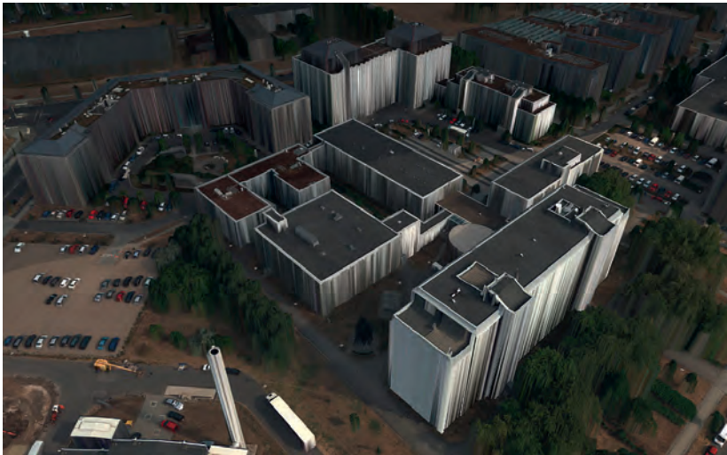
Abb. 4: Visualisierung von hoch genauen DOM und TOM: MultiCam, Auflösung ca. 7 cm, ohne manuelle Nachbearbeitung; Kanten und viele Details wie Dachaufbauten und Schornsteine sind exakt abgebildet.
