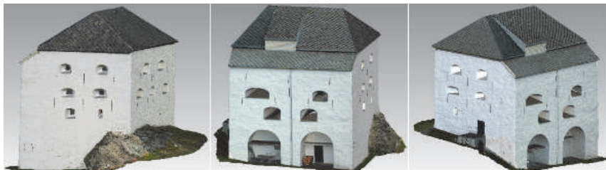
Abb. 2: Verschiedene Ansichten des Kristiansten Festungsgebäudes in Trondheim – Aufnahme durch Riegl VZ-400, Dreiecksvermaschung und Texturierung mit Geomagic
