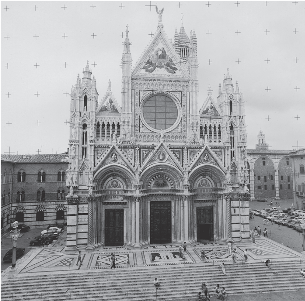
Abb. 3: Messbild der Eingangsfassade des Doms von Siena.
